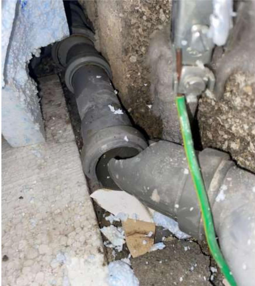
Bild 3: Bruch einer Hauptabflussleitung mit anschließendem Rattenbefall
